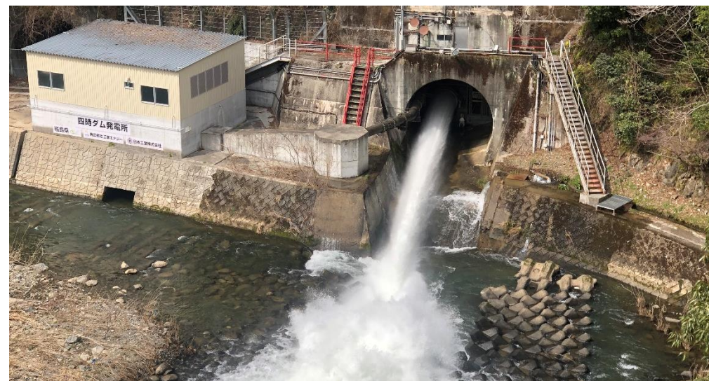
本社を含む3拠点に電力供給する四時ダム発電所（工営エナジーが運営）
