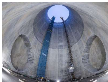
等々力非常口 立坑本体
