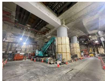
品川駅 軌道下掘削
