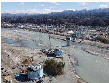
天竜川橋りょう 橋脚工
