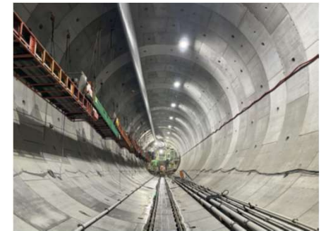
第一首都圏トンネル 梶ヶ谷工区 坑内の状況
