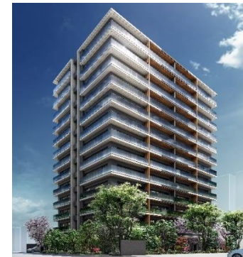
クリオレジダンス川崎南幸町 (2024年竣工)
