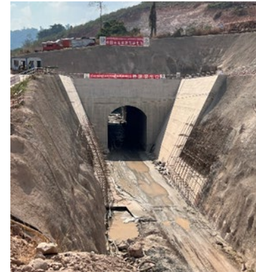
迂回トンネル
