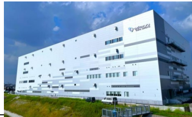
小田急不動産 ロジスティクスセンター岡崎
