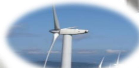
風力発電 地中配線
