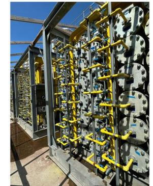
（左）化学工場でのH<sub>2</sub>分離の例。
