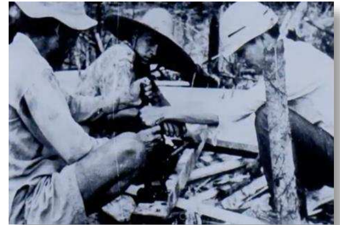
1961年 ベトナム戦争中に 729基の鉄塔を建設
