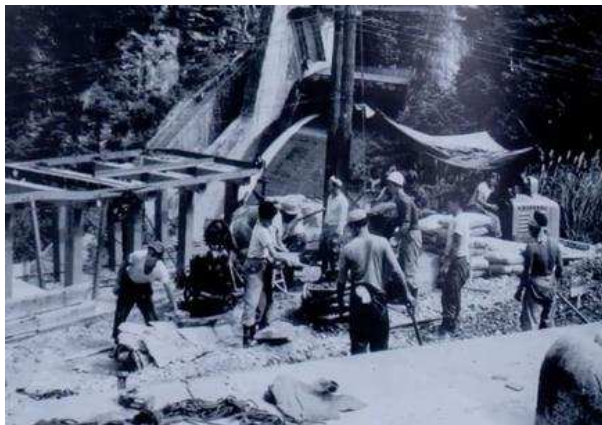
1963年 黒部ダム 電気工事完工
