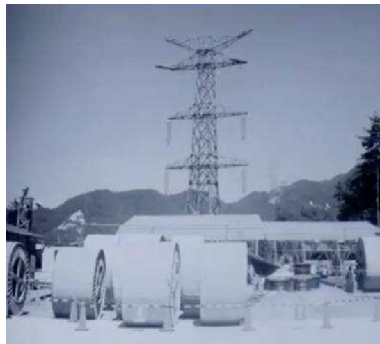
1988年 国内初100万ボルト 送電工事受注
