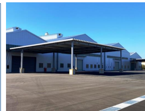
赤穂工場 新プラントの外観
