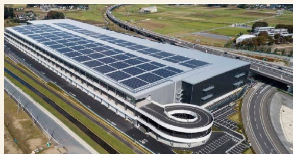
▲茨城県五霞町五霞インターチェンジ周辺土地区画整理事業 写真提供：日本GLP株式会社「GLP圏央五霞」
