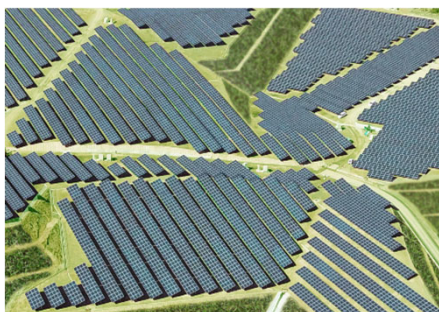
（角田市太陽光発電所）
