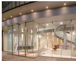
NTビル(エントランス)
