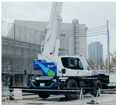
現場で活躍するフル電動ラフテレーンクレーン
