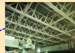
オペレーションフロアの天井(左)・壁面(右)の耐震補強
