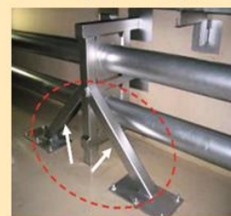
主蒸気配管(左)・建屋内配管(右)の耐震補強
