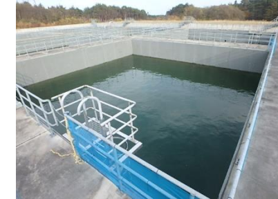
東通原子力発電所 淡水貯水槽
