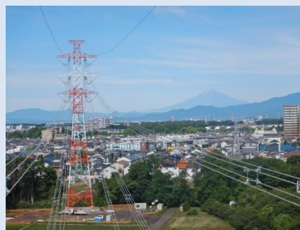
秦浜線鉄塔改修 (神奈川県)
