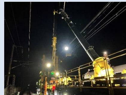
東北新幹線 電化柱建替 (福島県)
