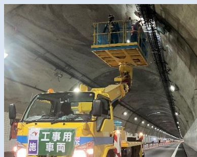
東海北陸自動車道 真木トンネル 照明設備新設・更新 (富山県)
