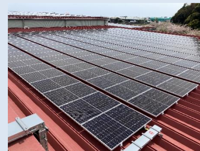
(株) 精工南国工場太陽光発電システム設置 (高知県)
