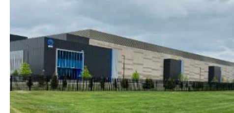
米国シカゴのデータセンター
