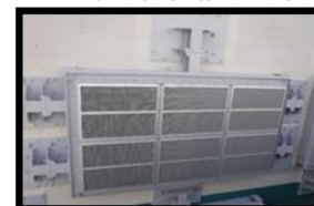
電巻防護ネット (複数箇所)
