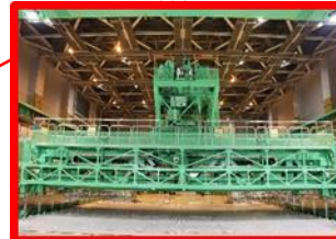
耐震強化工事を実施
