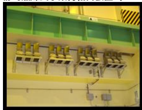
静的触媒式水素再結合装置 (PAR)
