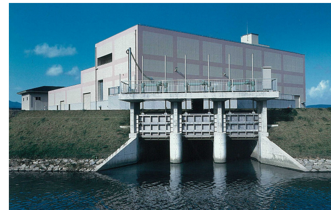
▲ 雨水排水機場/下川原雨水ポンプ場
