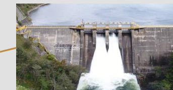
幌満川水力発電所
