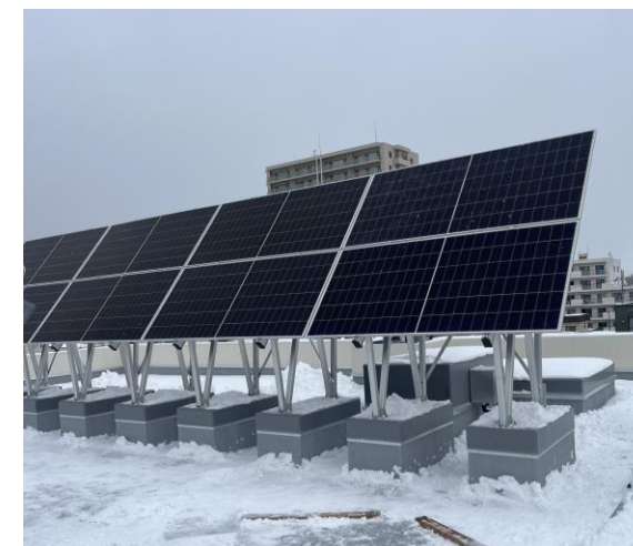
※北海道札幌市 施工事例
