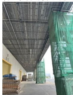
埠頭工事現場(吊り足場)
