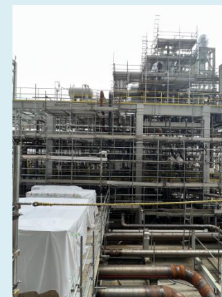
バイオマス発電所工事現場
