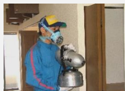
害虫防除施工
