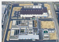
廃液処理工場
