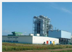
苫小牧発電所
