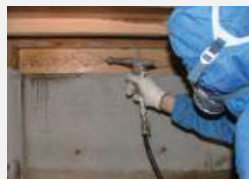
白蟻防除施工
