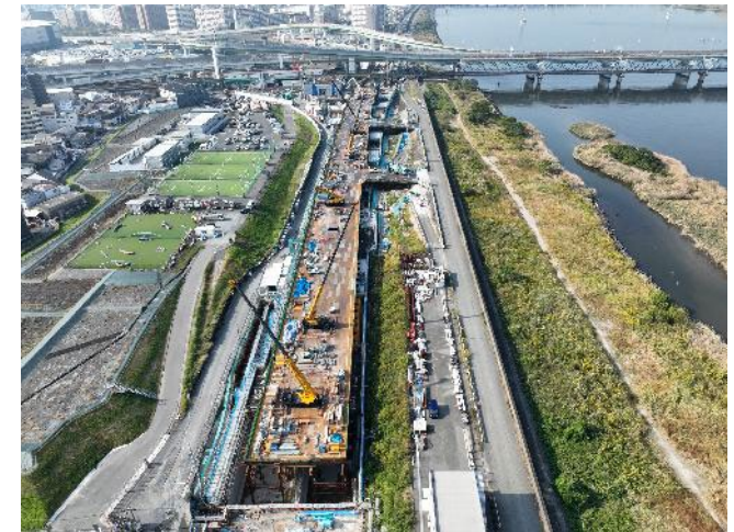
堤防一体型の道路工事に伴うCM
