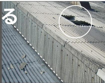
台風一過の屋根に上がって見ると、痛々しい爪痕が残る屋根(点線より右)のすぐ隣のSOSEIで補強された屋根(点線より左)は、ほぼ無傷でした。
